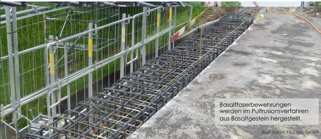
Basaltfaserbewehrungen werden im Pultrusionsverfahren aus Basaltgestein hergestellt.
